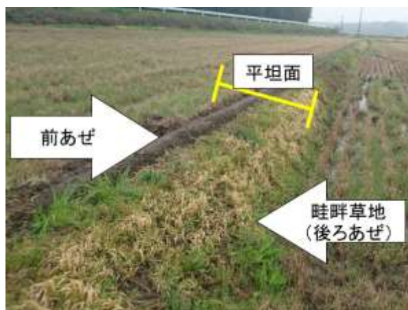
写真-1 現地水田圃場畦畔の様子 (茨城県牛久市)
