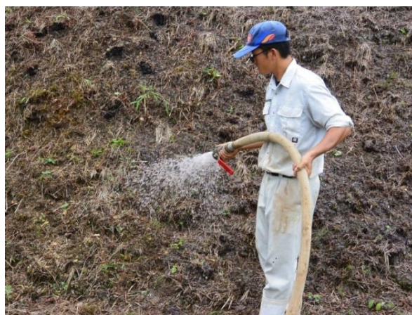
写真-6 吹付けによる施工
