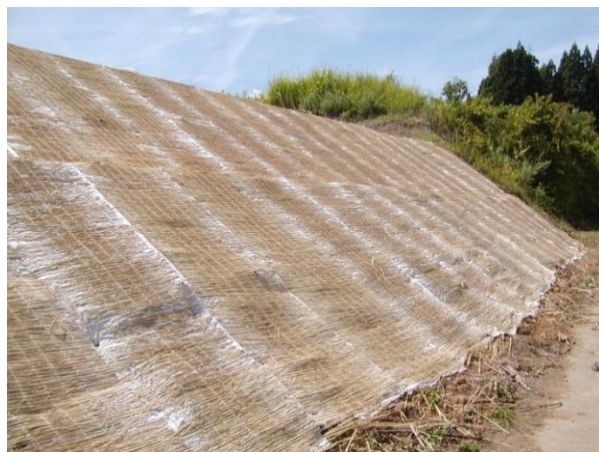
写真-5 長野県下水内郡栄村のワラ芝の施工事例
