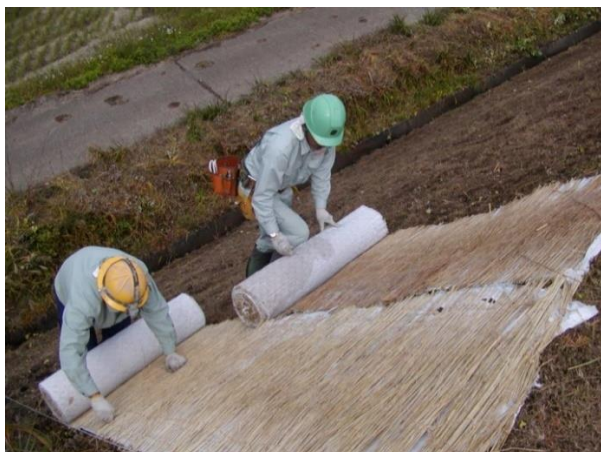
写真-4 ワラ芝による施工
